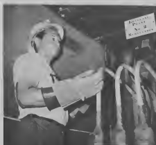
WHEN WORKING on high voltage equipment or lines, rubber and leather gloves are used. ORA TA traha riba equipo di linja di alta voltaje, handschoen di rubber y cuero ta ser usa.
